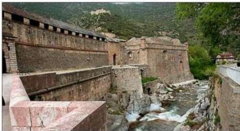
Les remparts pourraient bénéficier d'une restauration nécessaire.
